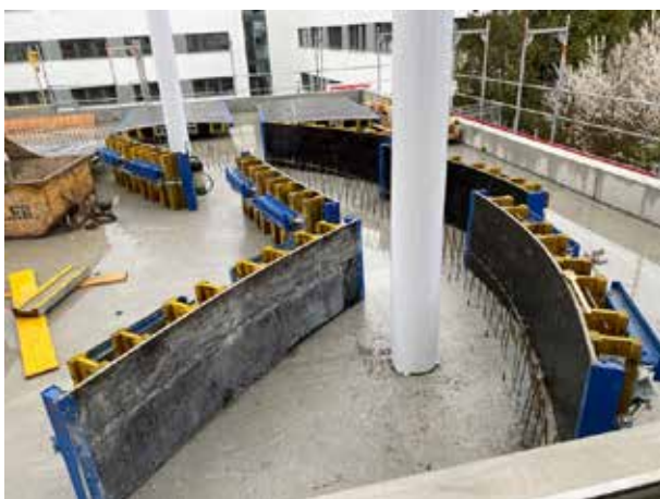
La base exterior de la elipse de la 1ª planta se está tapiando. Entre el techo de la primera planta y el suelo propiamente dicho de la primera planta hay espacio para la electricidad y otros conductos de suministro.
