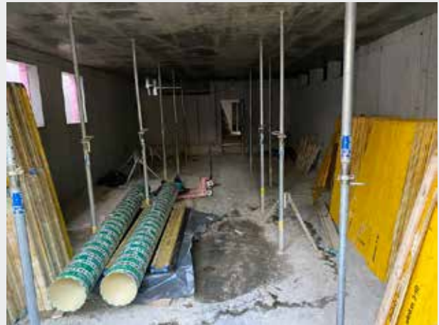
Vista de la zona delantera del sótano. Aquí es donde se ubicará el sistema de ventilación.
