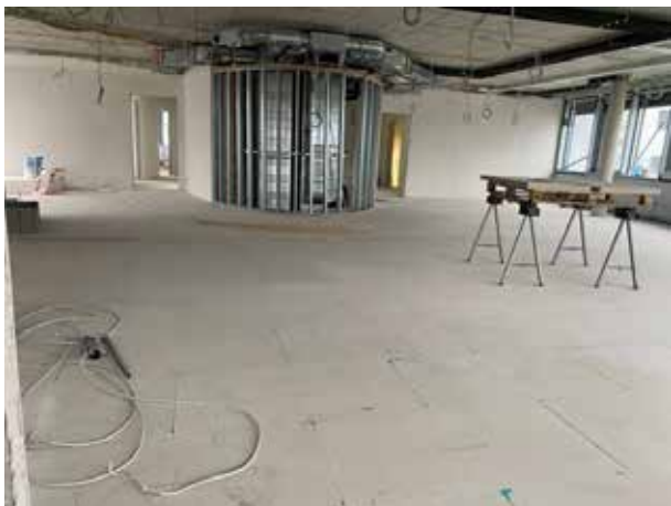
El suelo está terminado. Ahora toca cubrir los conductos y tuberías de ventilación que recorren la elipse de la escalera desde el sótano hasta el segundo piso. El armazón de montantes ya está colocado.
