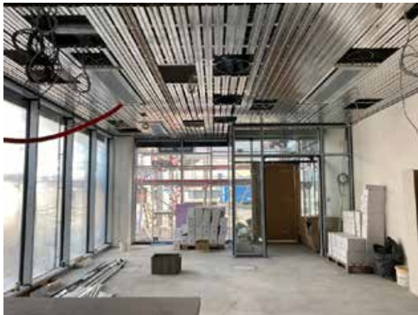
El techo de calefacción/refrigeración de la zona de entrada está casi listo para la colocación de las tuberías.
