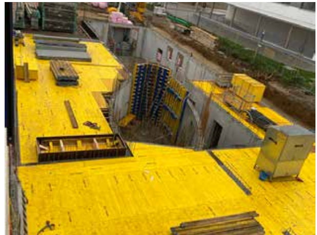
Todas las paredes interiores, incluida la intrincada elipse de la escalera, están terminadas y gran parte del techo del sótano ya está cubierto.
