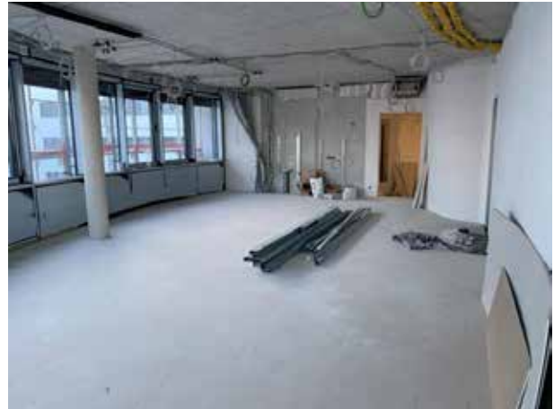
Todas las tuberías y cables han desaparecido bajo el suelo elevado.
