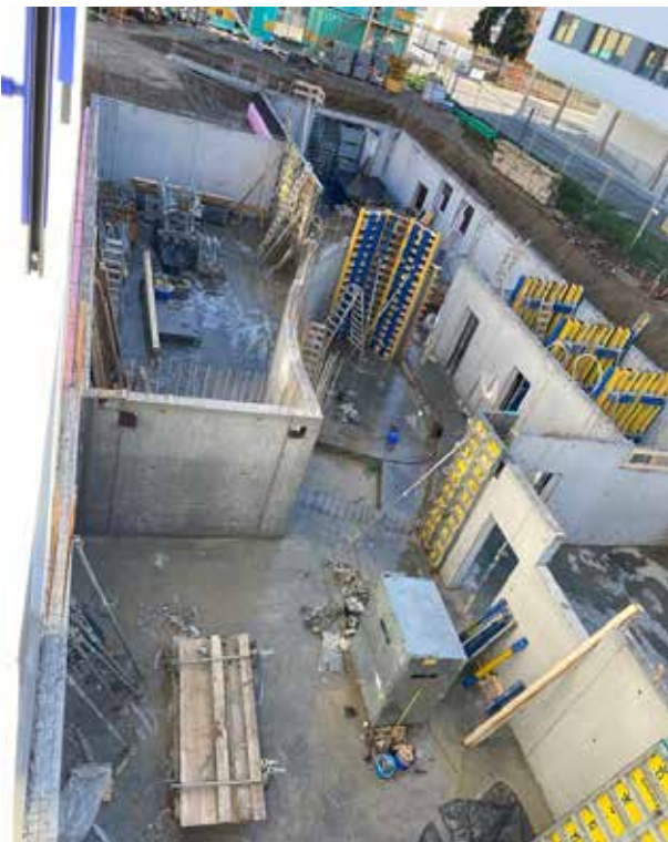
Casi todas las paredes interiores del sótano están terminadas. Solo falta una parte de la elipse de la escalera.
