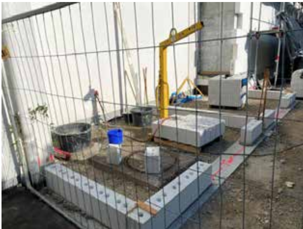
Las paredes de la ampliación están enladrilladas, pero el tejado se hormigonó de nuevo (por motivos de protección contra incendios).
