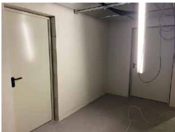
Ya se han instalado las puertas en el sótano.
