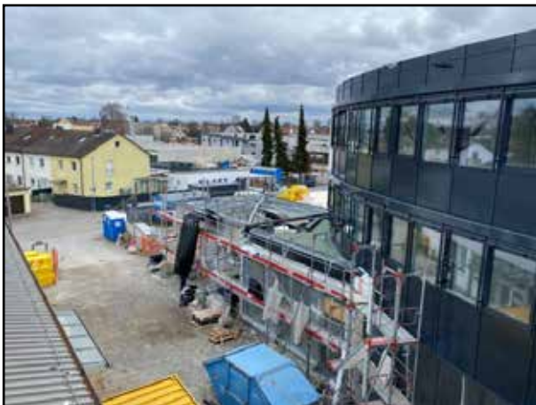
La estructura de acero ya está colocada. Ahora hay que drenar el techo de cristal antes de instalar los cristales.
