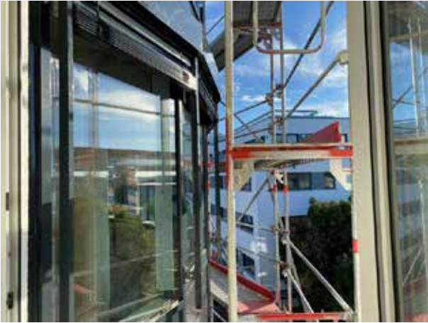
Las persianas están instaladas.
