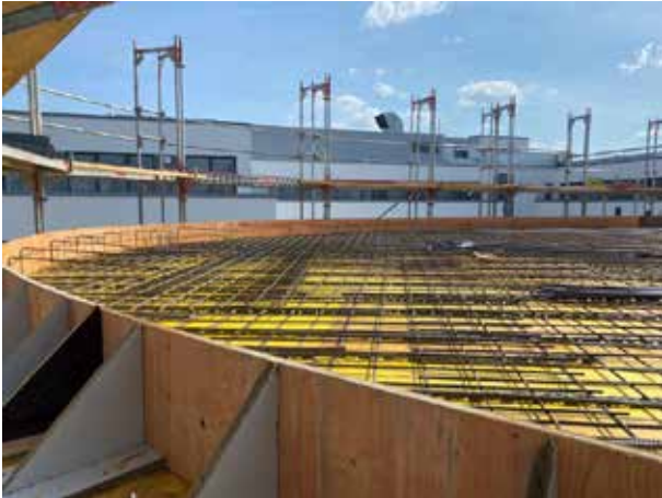
El entablado del techo de la 2ª planta casi parece una obra de arte.
