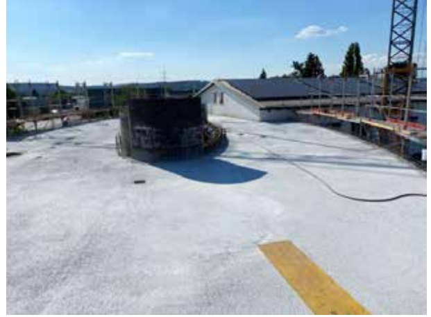
La elipse de la escalera del centro está abierta por arriba.
