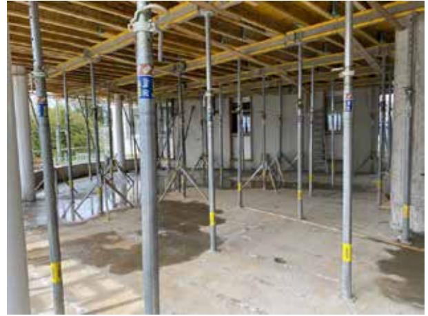
En la futura oficina de ventas, bajo toneladas de acero estructural y hormigón, todo va bien.
