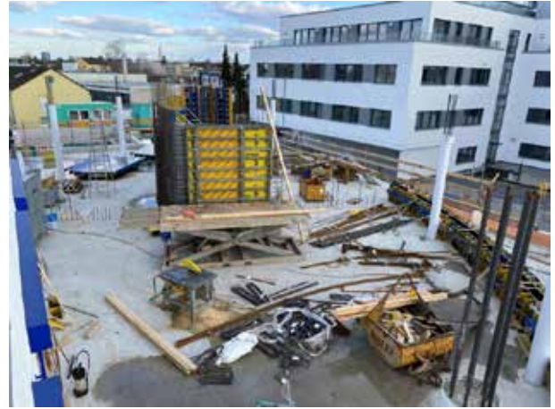
La escalera como elipse dentro de la elipse. A la derecha ya se ve el borde de la elipse. En el exterior habrá una zona verde.
