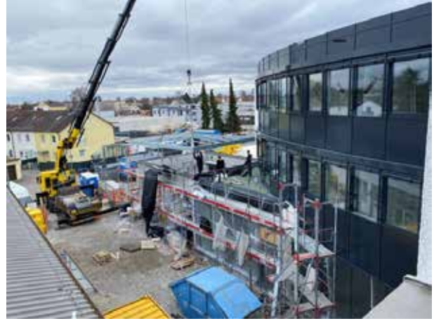
Se construirá un gran techo de cristal sobre la zona de entrada para que todo el que venga encuentre también un lugar seco delante del edificio. La construcción de acero para sujetar los paneles de cristal.
