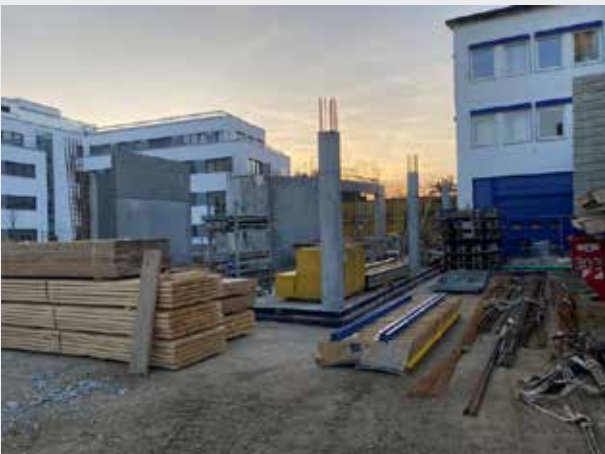
Vista desde el exterior de la futura entrada. A la derecha en la imagen nuestro edificio anterior, que será completamente renovado tras la finalización de la ampliación.
