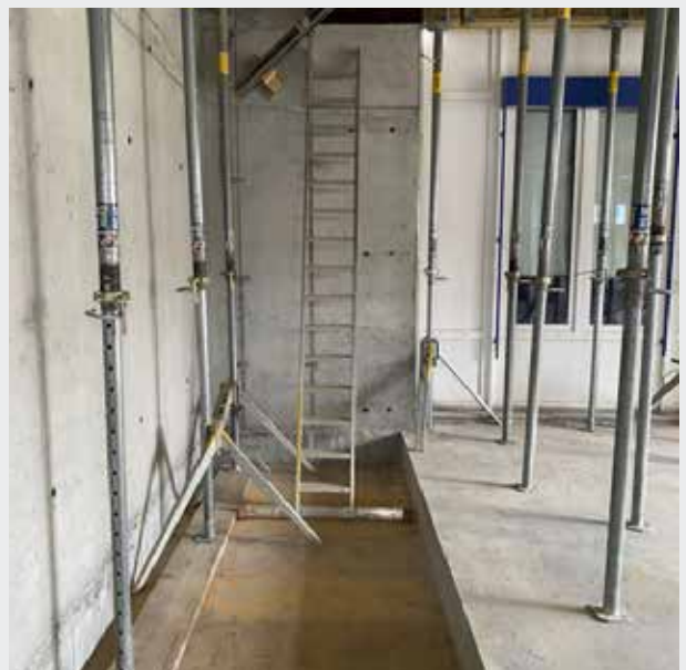
Aquí estará el almacén expendedor, que se extenderá desde el sótano hasta el techo de la primera planta.
