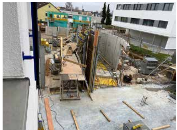
Otra vista desde la parte trasera de la futura escalera. Solo falta un punto en el que aún no se ha colocado el revestimiento exterior, por lo que pronto podrá comenzar el hormigonado del muro de la escalera. La planta baja está tomando forma y pronto las fotos de la obra tendrán que hacerse desde la 2ª planta del antiguo edificio.
