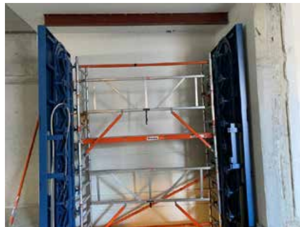
Se han montado los andamios para el resto de los trabajos de montaje; he aquí una vista de los mismos en la planta baja.
