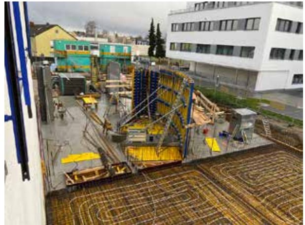
Por fin se han colocado las líneas de calefacción. En la zona delantera, se trabaja intensamente en el encofrado de la escalera.
