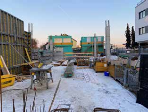
Aquí estará el almacén y la cocina para las aulas de formación y conferencias de la parte delantera.
