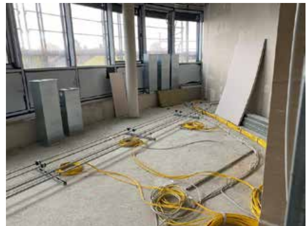
Todavía se están colocando más tuberías y cables en el suelo de la 1ª planta.
