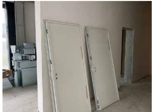
Y también se están instalando las puertas cortafuegos. Aún están pendientes de instalar en la planta baja.
