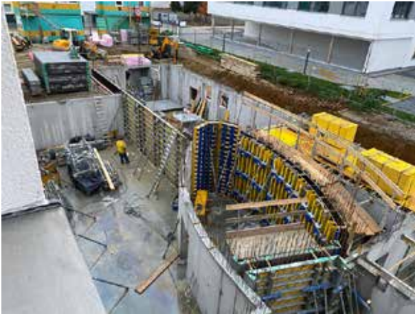
El resto de las paredes interiores del sótano están encofradas, listas para verter el hormigón.
