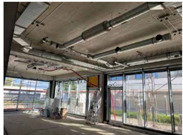
También se están instalando tuberías de ventilación en la sala multifuncional.
