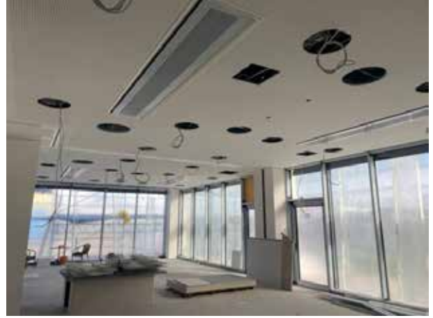
Un poco más tarde, se instala el techo insonorizante definitivo.
