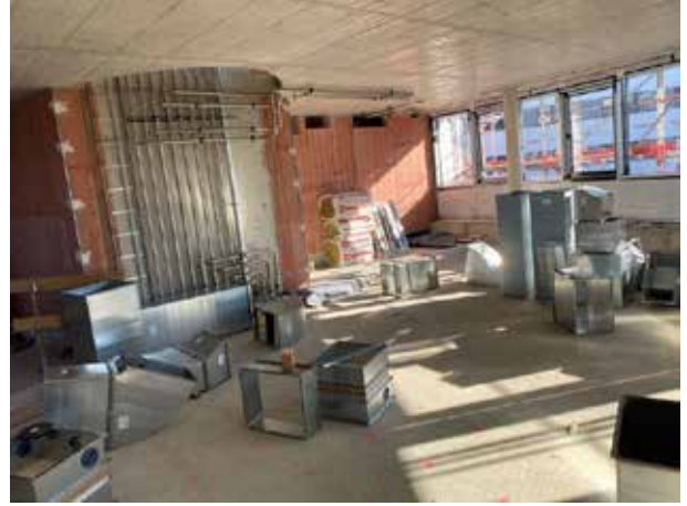
Ya se han imprimado los muros de hormigón de la oficina diáfana de la 1ª planta y se están instalando los conductos de ventilación.
