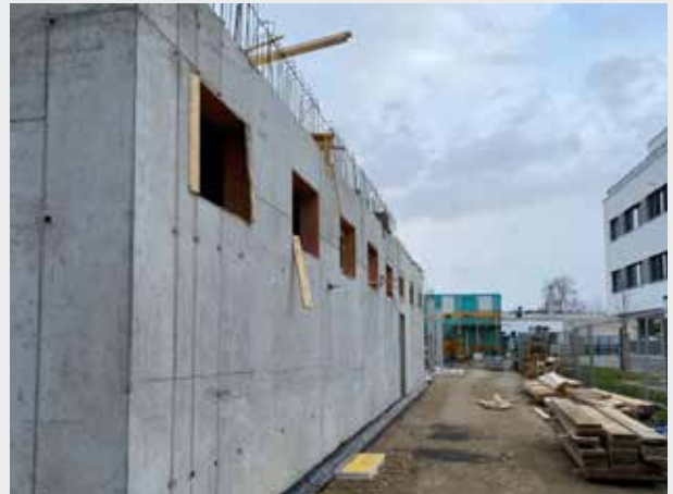
El muro de carga desde el exterior. Durante la semana también se rellenó aquí la fosa de excavación. En breve se montarán aquí los andamios.
