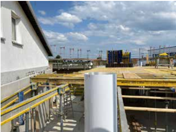
Aquí, el nuevo edificio se "acopla" al existente.
