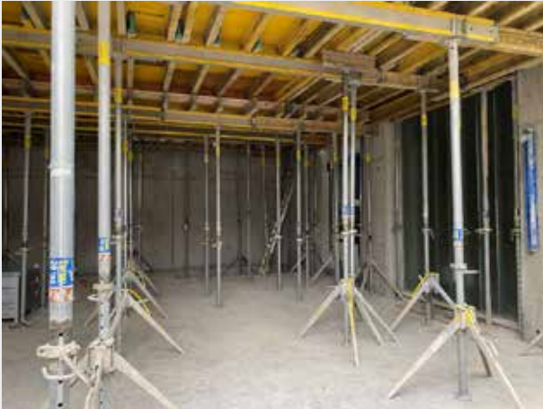
En el almacén: el entablado del techo desde abajo.
