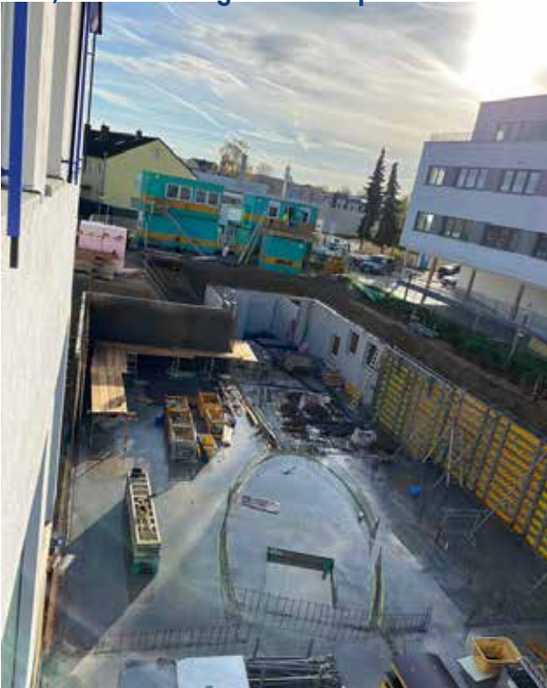
El resto de los muros exteriores se están encofrando y hormigonando.
