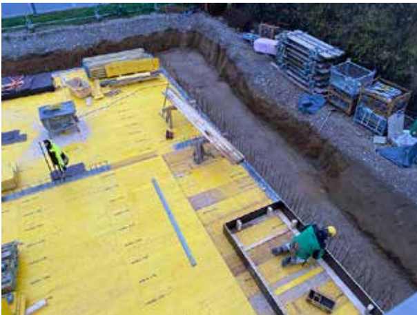
Se está formando el paso en el techo del sótano al primer piso. Aquí estará nuestro sistema de almacenamiento, para que siempre dispongamos de espacio suficiente para tener suficiente stock y poder realizar entregas con rapidez.
