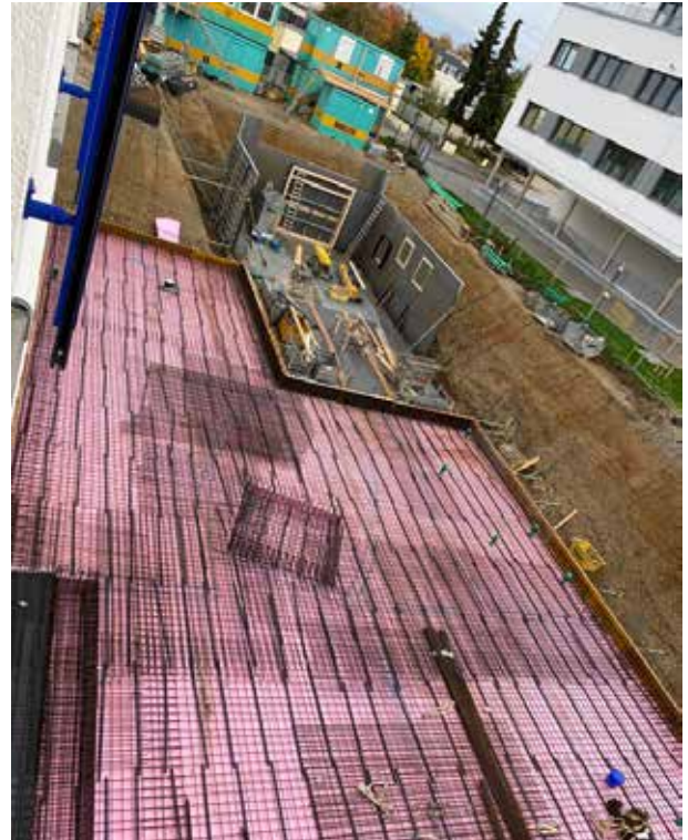
Los obreros del acero están trabajando duro y el encofrado para los primeros muros del sótano se está levantando en la zona delantera.
