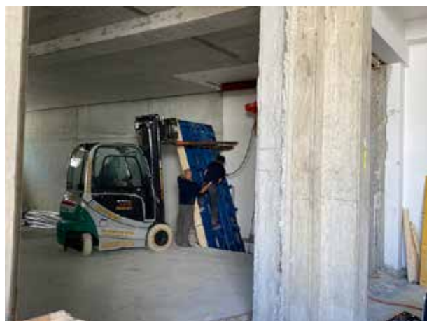
La inserción de los paneles laterales es un trabajo milimétrico.
