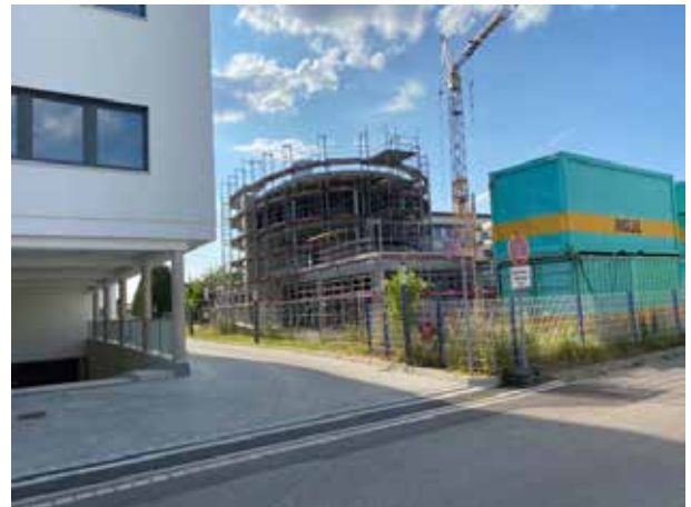
La estructura del edificio ya está terminada.
