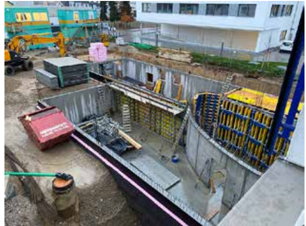
Alrededor del sótano, la fosa ya se ha rellenado en muchos lugares, y proporciona espacio de almacenamiento adicional para el material de construcción. En algunos lugares ya se ha empezado a colocar la cubierta del techo del sótano.
