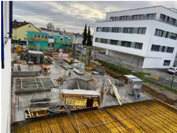
Tras las vacaciones de invierno, los trabajos continúan a toda marcha en la zona delantera. Solo la zona trasera del almacén sigue a la espera de que se instalen los circuitos de calefacción. Un detalle: la escalera elíptica con el "puente" que lleva de un lado a otro.
