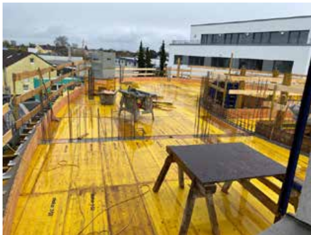
... hasta que está completamente montado alrededor.
