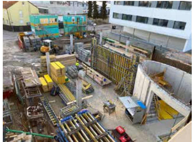
En esta foto ya se ven los primeros peldaños de la escalera.
