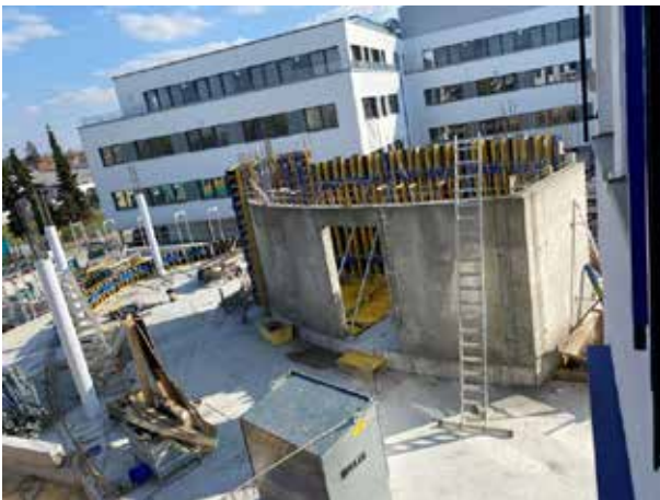
Un lado de la elipse de la escalera y parte de la base están listos para hormigonar.
