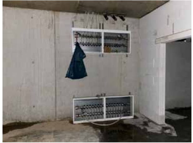
Primeros indicios de que se está instalando la calefacción en esta habitación del sótano. Trabajamos de una manera respetuosa con el medio ambiente con una bomba de calor.
