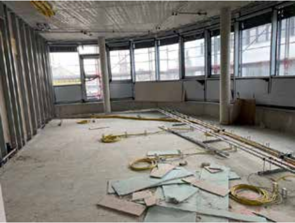
La futura sala de descanso del personal con su propia terraza.
