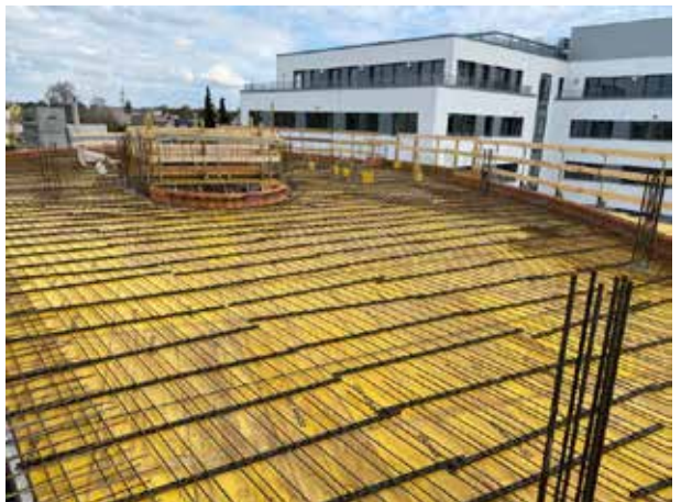
La primera capa de acero estructural está aquí...
