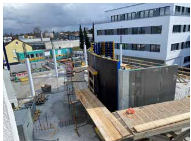
Los contornos de la elipse de la escalera de la 1ª planta ya son visibles a través del encofrado. Mientras tanto, también se han hormigonado las columnas de la zona delantera.
