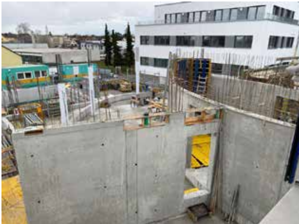
Vista sobre el muro desde la oficina de ventas hacia la sala de reuniones/sala de recreo y las terrazas de la azotea.
