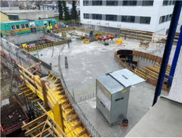
Se ha hormigonado el techo, y ahora ya se puede ver claramente la forma elíptica.
