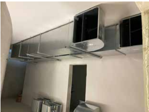
Los primeros conductos de ventilación se instalan en el sótano.
