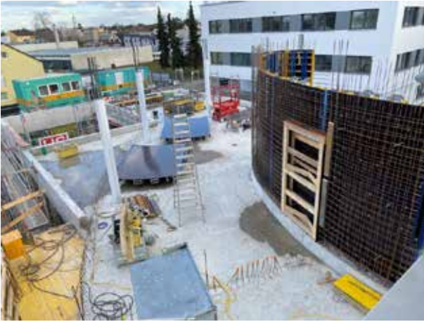
Se ve claramente dónde estará más adelante la apertura de la escalera. La zona a la izquierda de las dos columnas fuera de la elipse se convertirá en una pequeña terraza para la sala de reuniones. Al fondo, se ve la terraza de la azotea frente a la sala de descanso del personal.
