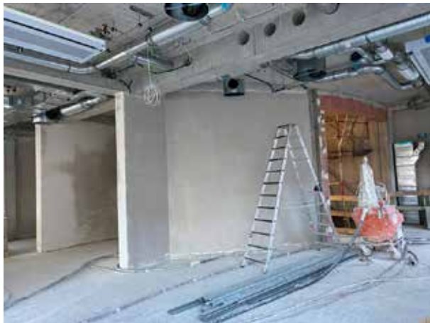
Ahora también se están enluciendo las paredes de la planta baja.
