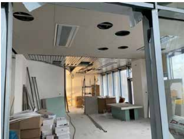
En la zona de la entrada, aún falta el techo definitivo en la zona trasera. También falta por instalar la cortina de protección contra incendios frente al hueco de la escalera.
