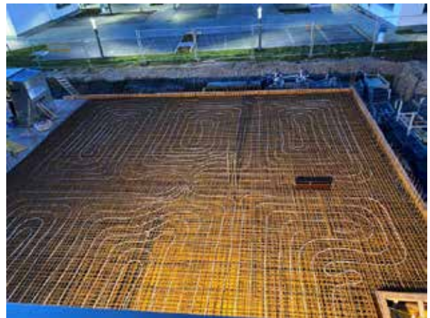
El 16 de enero, el techo del sótano de la zona del almacén está listo para hormigonar. ¿Nos acompañará el tiempo? Se prevén heladas.
