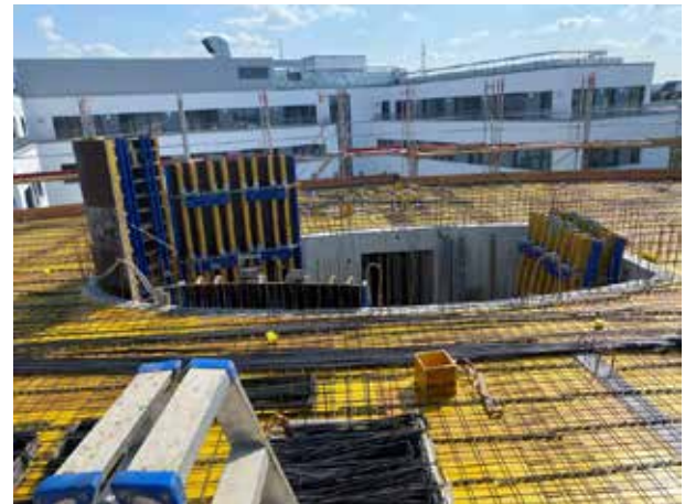
Aquí también claramente visible: la escalera "abierta" hacia arriba.
