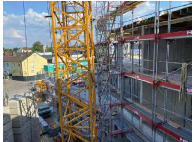
Vista de la ampliación desde la 2º planta del antiguo edificio
