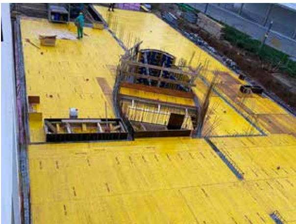
La cubierta de todo el techo del sótano está acabada. En la elipse se ve el "puente" que lleva de un lado a otro de la escalera. Ahora es el turno de los armadores de acero.
