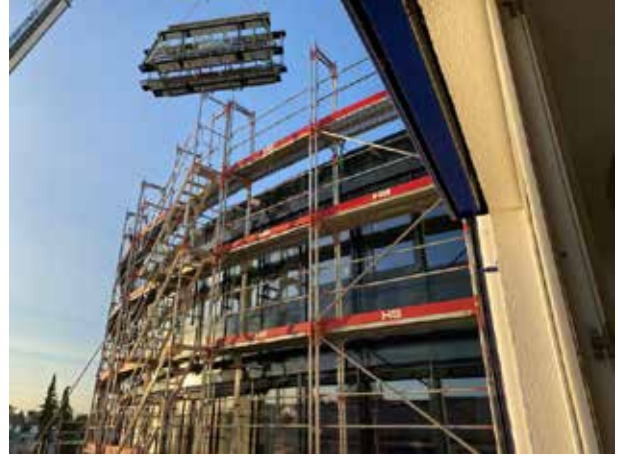
Los marcos del techo de cristal sobre la escalera flotan en el aire.
