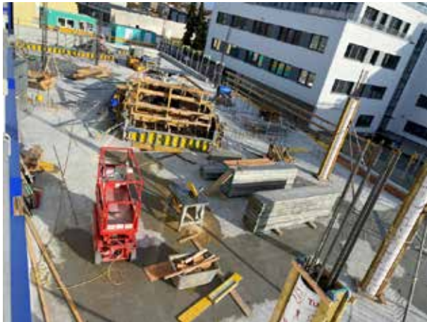
En la zona delantera, los soportes aún no se han tapiado.
