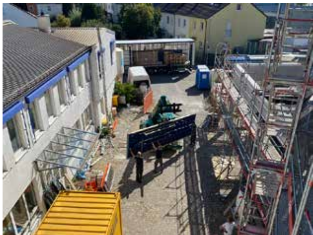
Las secciones laterales de la máquina de almacenamiento, de casi 7 metros de longitud, deben transportarse al lugar de instalación, una tarea nada fácil.
