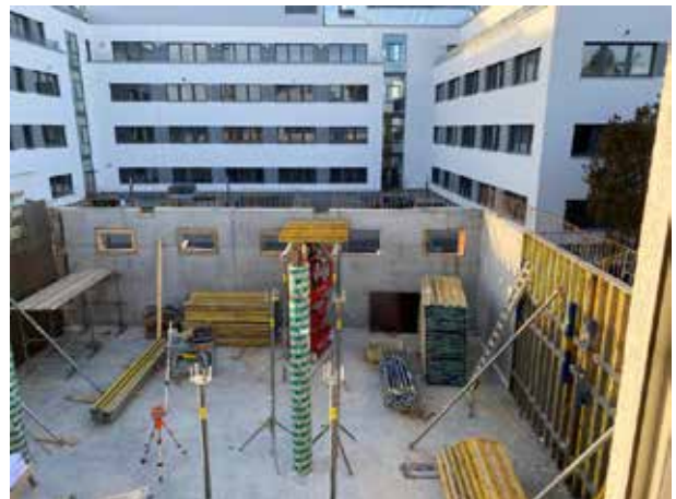
Se ha empezado a cubrir el techo de la planta baja.
