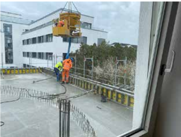
La obra justo delante de la ventana de la oficina: se están hormigonando los bordes de la zona del tejado. Aquí también, el acero estructural muestra claramente los contornos de la segunda planta.
