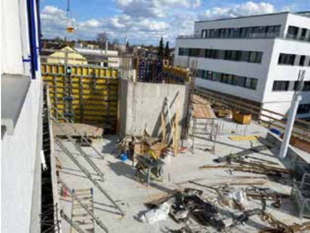
Después de formar la elipse de la escalera en el segundo piso, la primera pared...
