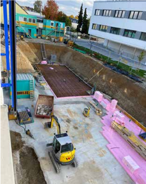
Lo único que falta es el hormigón en la zona delantera del sótano.
