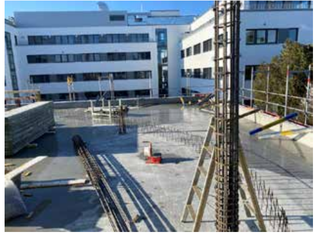
A continuación, se crean las columnas que sostienen el techo de la 1º planta.
