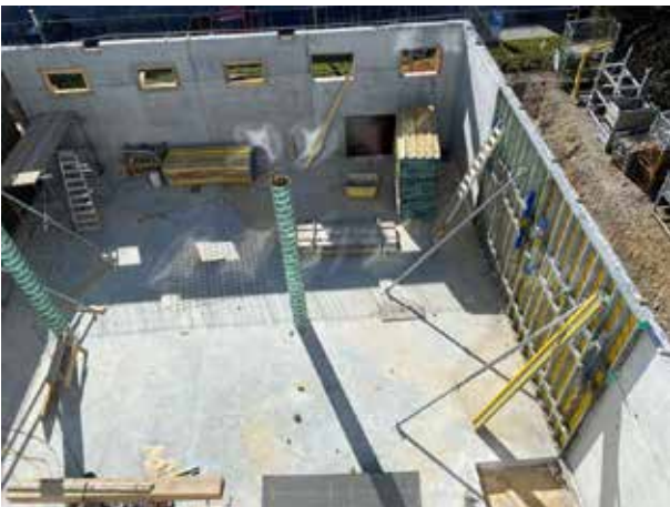
Vista desde la 2ª planta a la zona del almacén.
