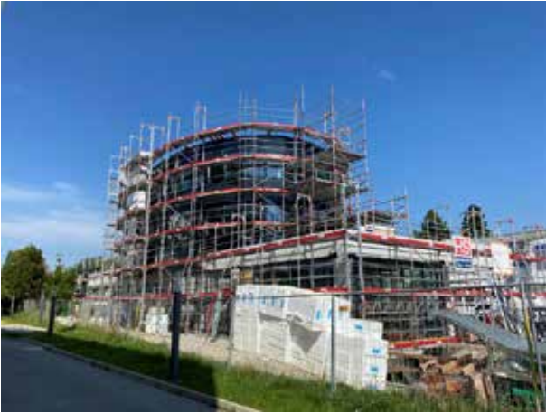
Vista del anexo desde la calle
