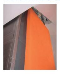
En cada estructura se asegura una ventilación suficiente mediante una chapa perforada bajo el anillo superior. La superficie de ventilación depende de la superficie del hueco y de la altura del sistema.
